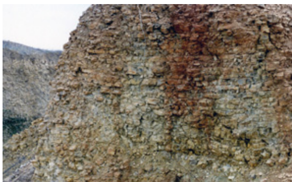
Фото 50. Трещиноватые слоистые известняки с ожелезнением. Пермь, казанский ярус. Ивантеевский каменный карьер, Ивантеевский р-н, Саратовская обл. Фото А.В. Елизарова, 1997.
