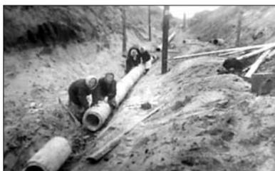
Фото 8. Укладка труб придамбового дренажа
