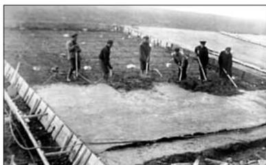
Фото 9. Укладка бетонных карт на мокром откосе
