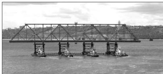
Фото 8. Транспортировка пролёта № 3 21.07.2007 г.
