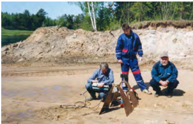
Фото 3, 4. Н.Л. Небритов. Работа в ООО «Пайплайн Сервисез ЛТД». Строительство переходов под руслами рек. Май 2002 г.
